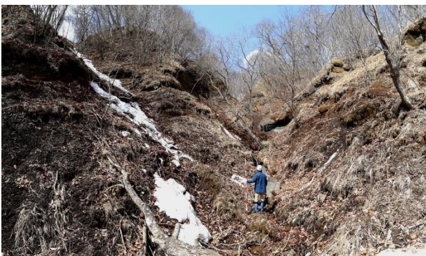
図-2 対策前の溪流の荒廃状況。溪岸斜面から多数の崩壊地形が認められる。
