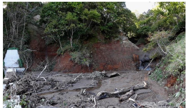
図-3 施工直後に起きた集中豪雨により発生した土砂流出に対して治山ダムが流出土砂を補足した状況。
