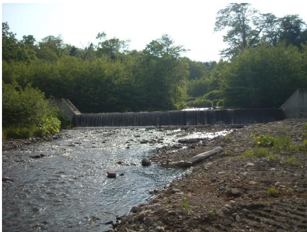
図-2 No. 2 床固工の魚道設置前の状況。
