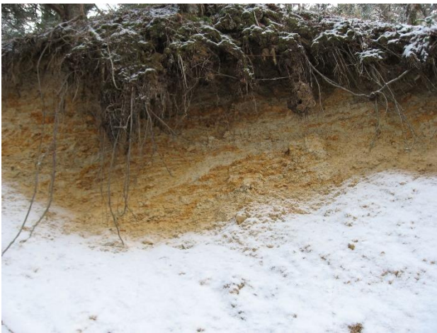
図-6 地すべり移動体下部が対岸に乗り上げている。
