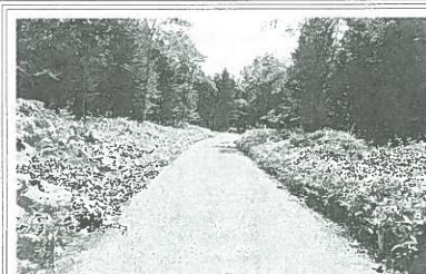
▶工事部門 森林室発注 林業専用道65林班線その2開設
