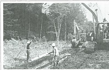
▶工事部門 農村振興課発注 畑地帯(営農用水)虹別地区61工区
